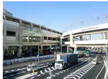
京急本線鉄道高架化に伴い整備が進む京急蒲田駅周辺
