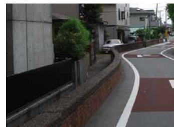
大正7年に多摩川の河川改修で つくられた羽田レンガ堤
