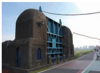
昭和6年竣工の六郷水門 (多摩川沿い)
