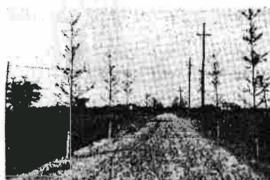
↑「河原坂」下、より多摩川土手方面を望む(昭和9年)
