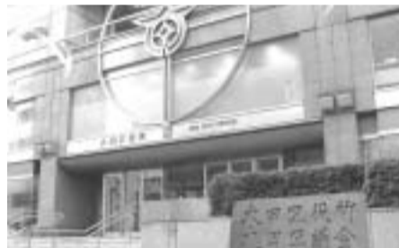
大田区役所本庁舎
