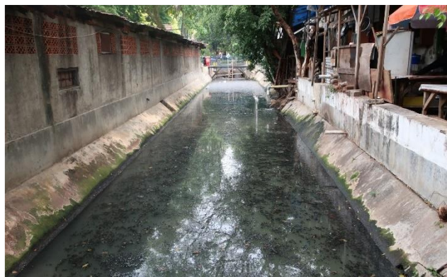
ジャカルタ市内排水路
