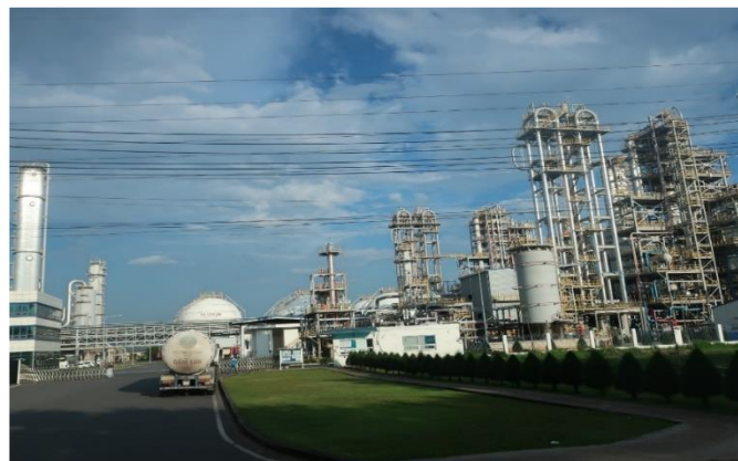
フーミー 3 特別工業団地 石油化学プラント
