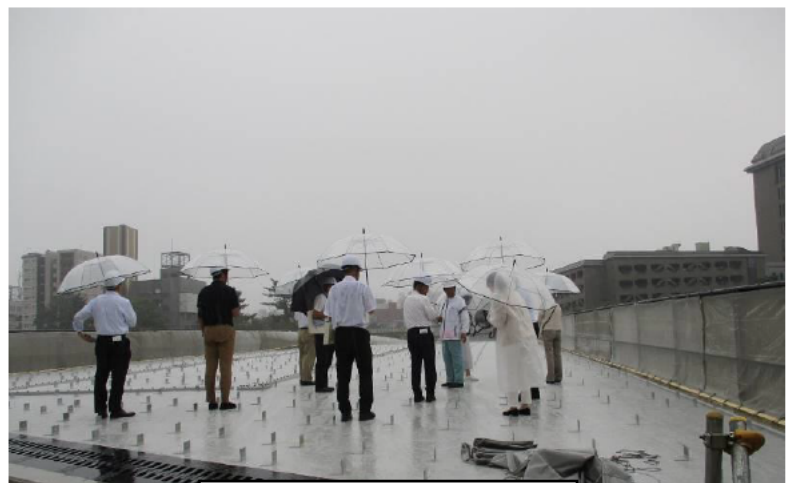
建設中の桜城橋を現地視察
