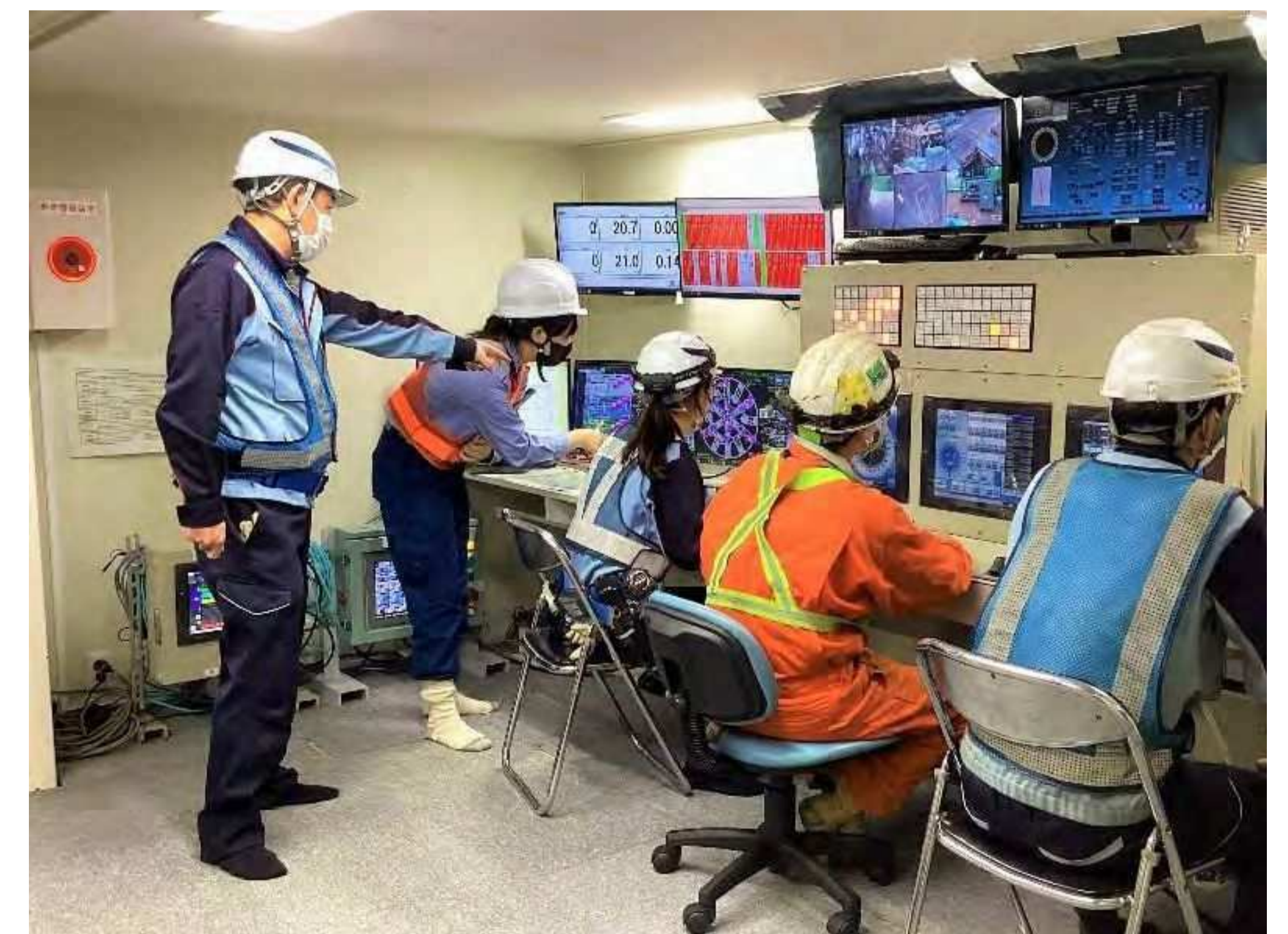
泥土圧の確認状況
