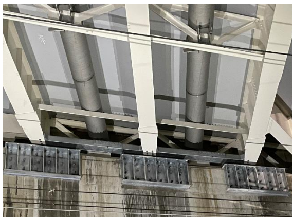
新根方橋 昭和 38 年竣工
