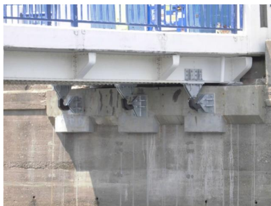
天神橋 昭和 36 年竣工（上部）
