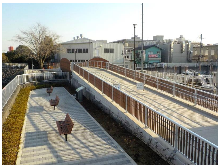
海辺の散策路の整備（いつつのわ水門橋）
