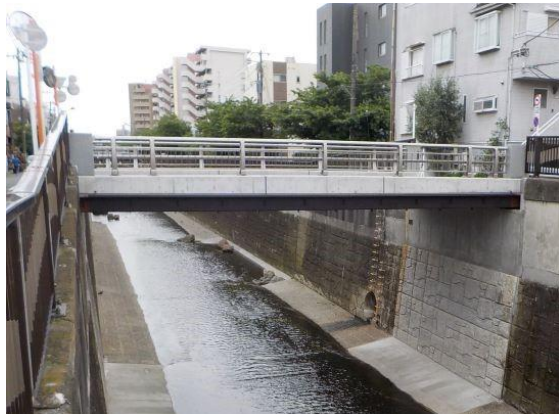
長栄橋 昭和 42 年竣工
