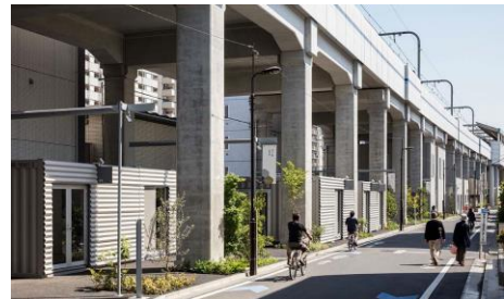
京急本線の高架下を活用した コワーキング施設「KOCA」(出典：東京都)
