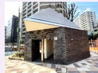
公園トイレのバリアフリー化
