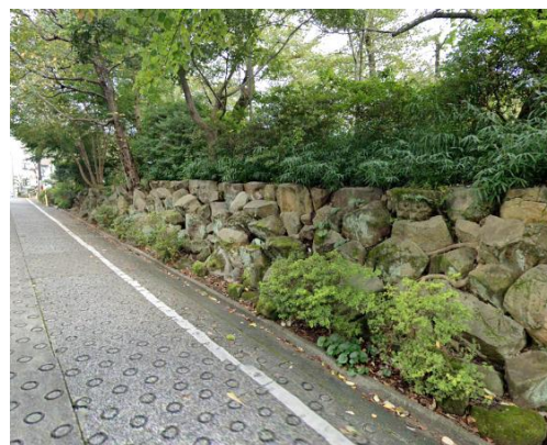
生物生息空間を創出する擁壁工事
