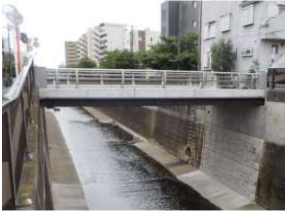
長栄橋 昭和 42 年竣工
