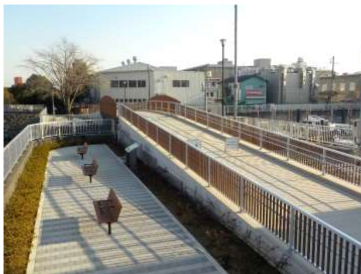
海辺の散策路の整備（いつつのわ水門橋）
