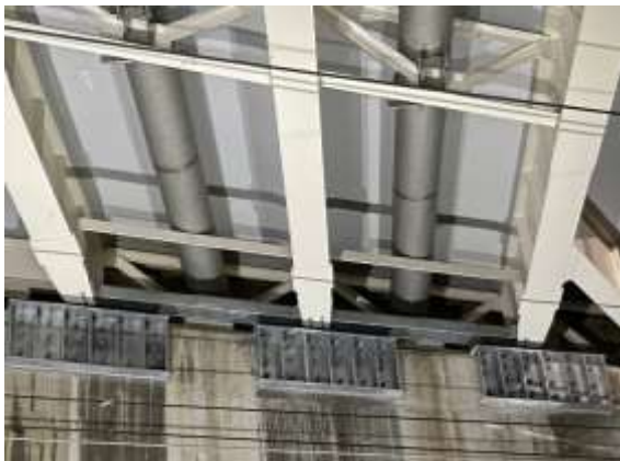
新根方橋 昭和 38 年竣工
