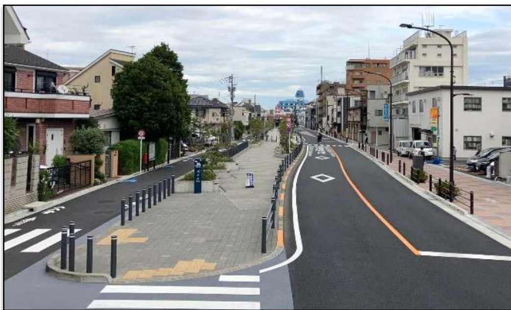
電線類が地中化された事例 （大田区画街路第１号線 北千束二丁目）
