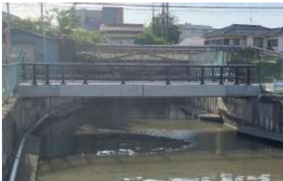
新田橋 令和 7 年竣工（上部）
