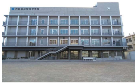
安方中学校 新校舎棟
