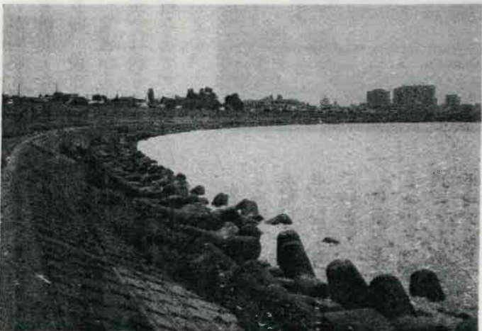
今の堤防は明治43年の最高水位より1.5m高い出水量に耐えられるよう築かれたが、自然の地形そのものは変わっていない。テトラポットが水勢をそぐために並んでいる。
