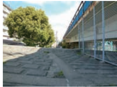
＜JR鉄橋と堤防の傾斜＞
