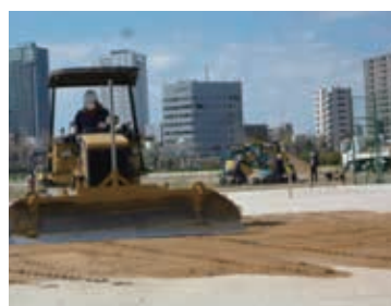
＜多摩川緑地の復旧工事＞
