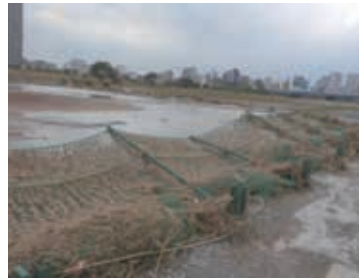
＜多摩川河川敷の被害状況＞
