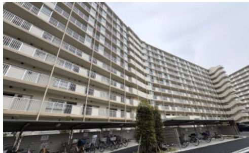
都営住宅新三号棟の様子
