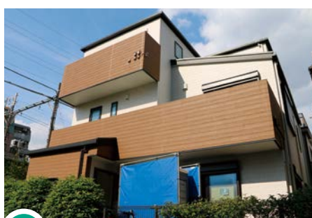
新築工事(令和3年4月12日)
