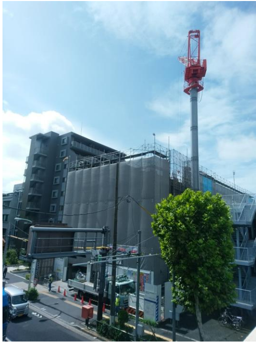
躯体工事 外部
