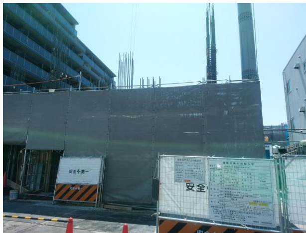
躯体工事 外部
