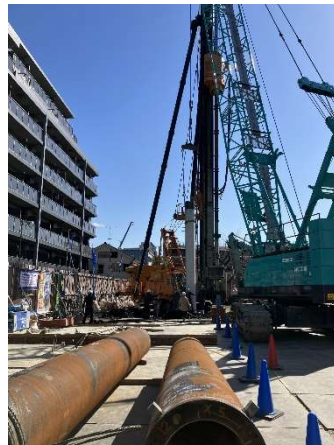
地業・土工事
