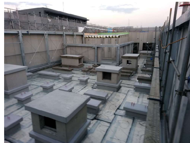
屋上防水工事
