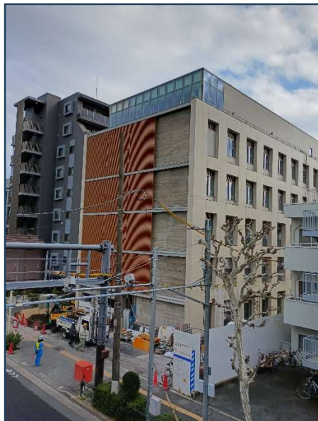
足場解体工事 北側
