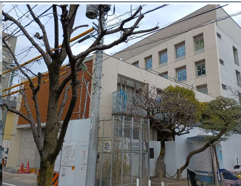
足場解体工事 西側
