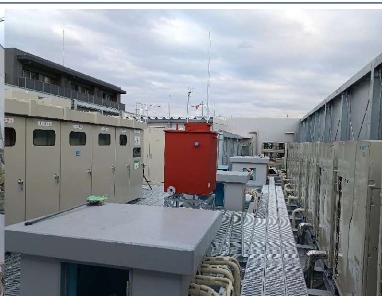
設備機器設置工事 屋上
