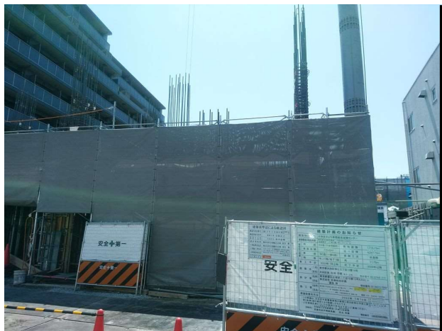
躯体工事 外部
