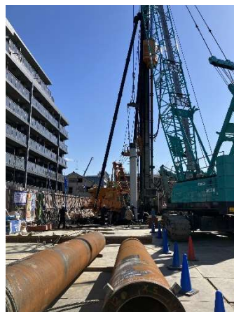
地業・土工事
