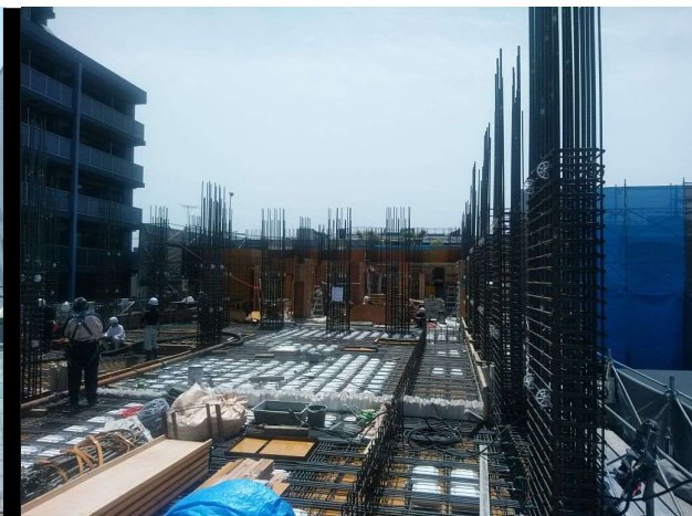
躯体工事 2階内部
