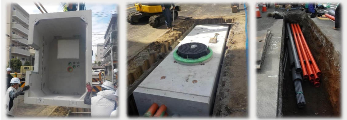
電線共同溝整備工事
