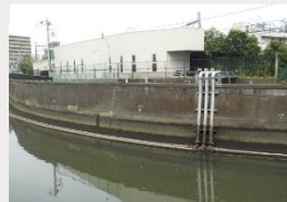
浄化施設建屋全景
