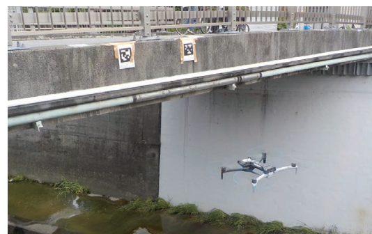
ドローンによる橋梁点検
