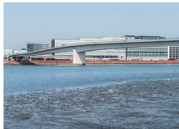
多摩川スカイブリッジ
