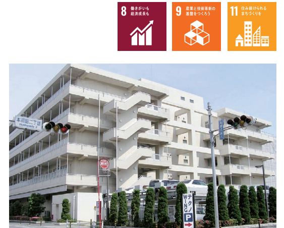
本羽田二丁目第2工場アパート
