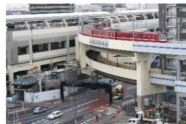
京浜急行線連続立体交差事業※
