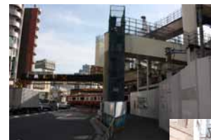
京急連続 立体交差事業工事
