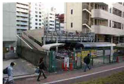
既存自転車駐車場
