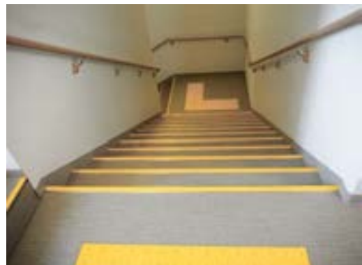
階段の段鼻の視認性の改善 (志茂田福祉センター)
