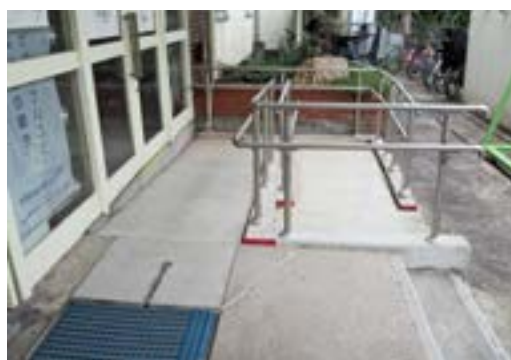
災害時に避難所となる施設のバリアフリー化 (新宿小学校)
