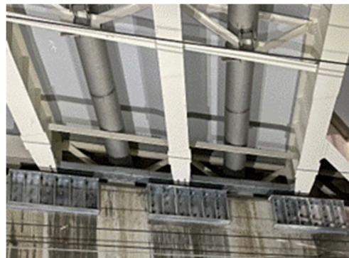
図 3.6 耐震補強段階①の例
