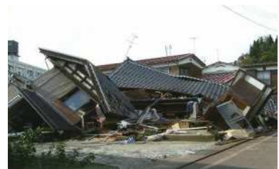
倒壊家屋の現場写真
