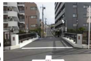
本村橋(平成 28 年度耐震補強完了)
