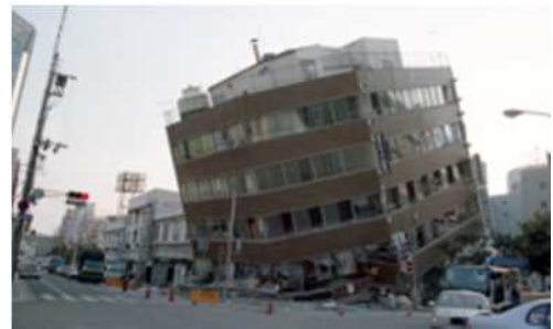
建物が倒壊し、通行が危険な様子 写真提供：神戸市
