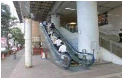
1 2階既存エスカレーター
