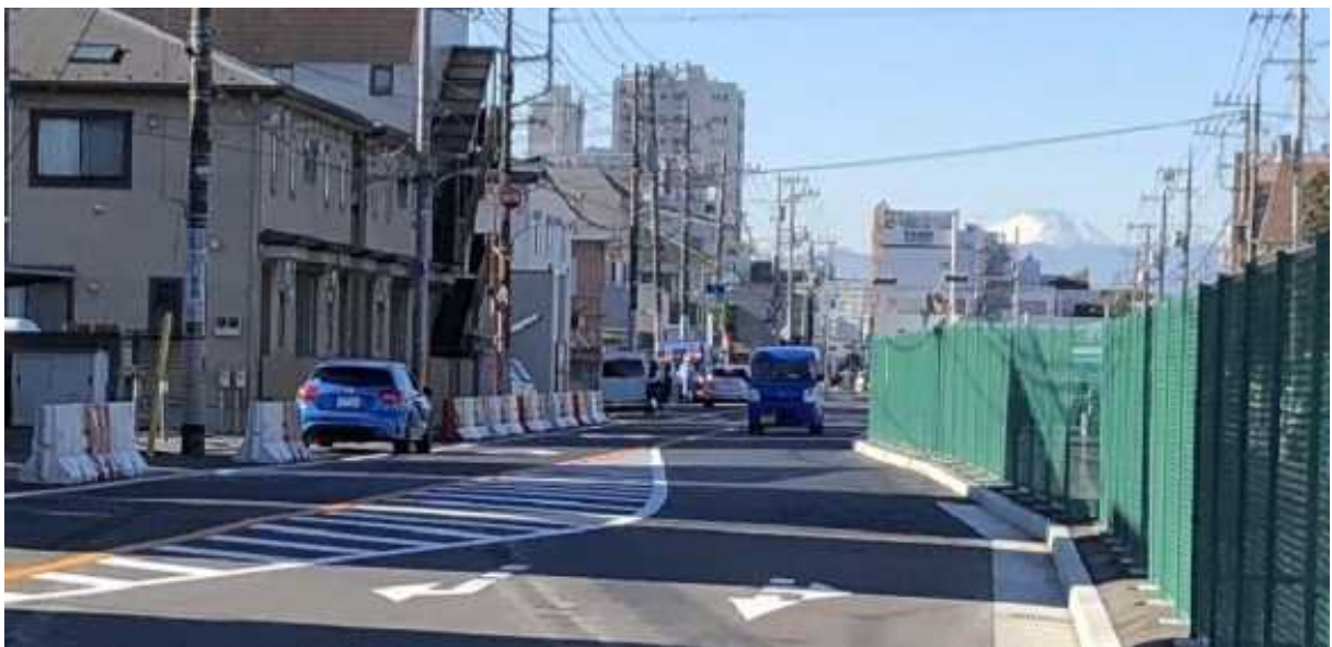
大田区画街路第 1 号線 工事中箇所(平成29年12月撮影)
