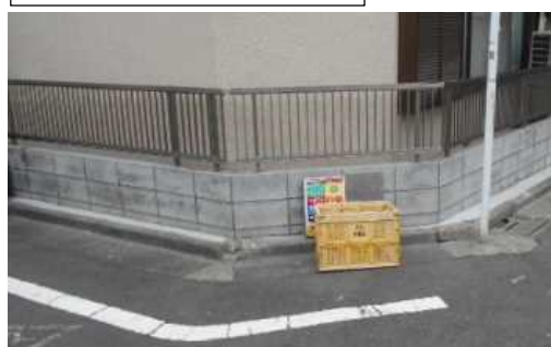
改修後のフェンス
