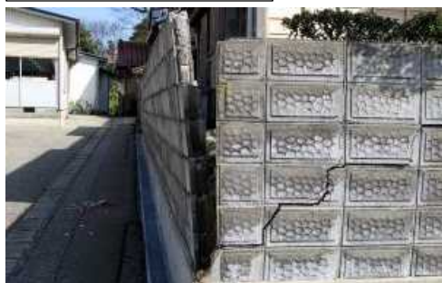
改修前のブロック塀
