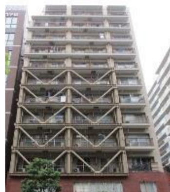
【助成金を活用した耐震化工事例】
