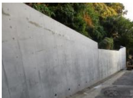
【助成金を活用した擁壁整備工事例】
