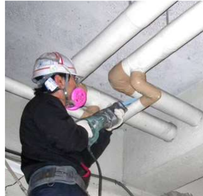
■配管エルボ除去作業
