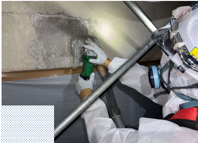
■外壁塗装材除去作業
