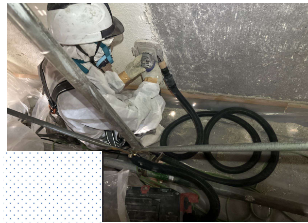
■外壁塗装材除去作業
