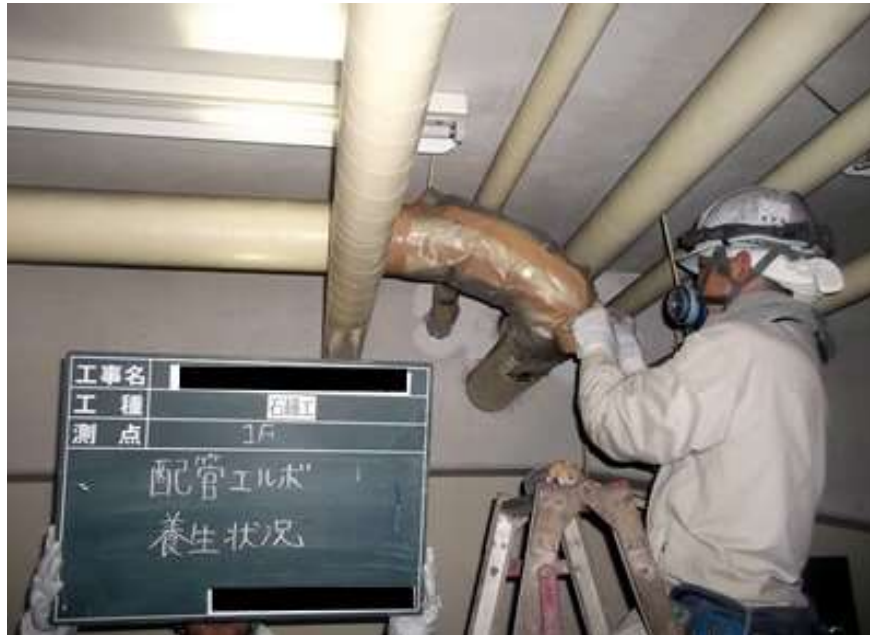
■配管エルボ除去作業
