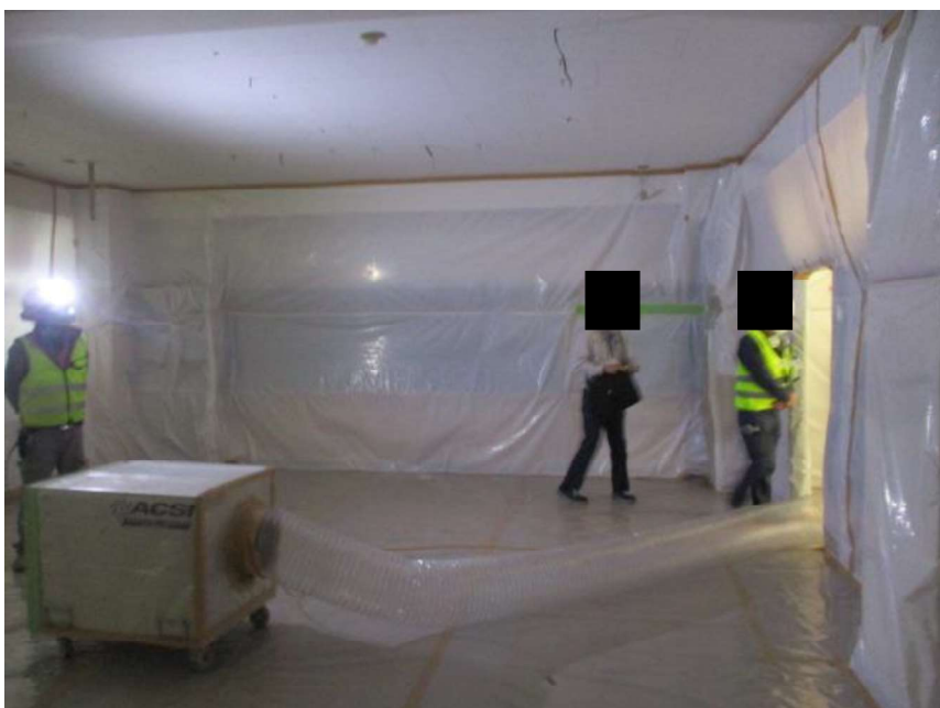
コンクリート面への付着防止措置
