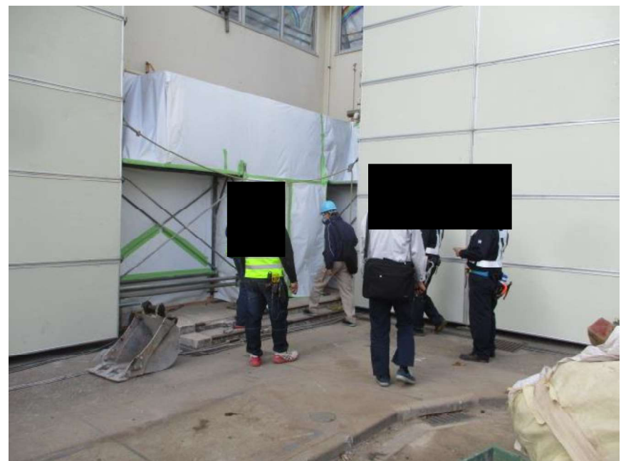
コンクリート底部分飛散防止措置
