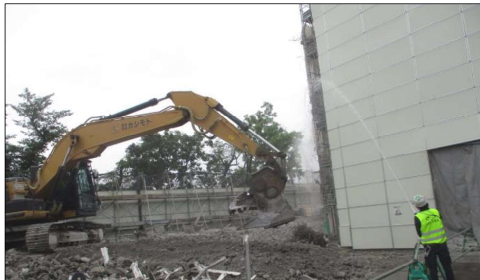
コンクリート小割作業(散水)
