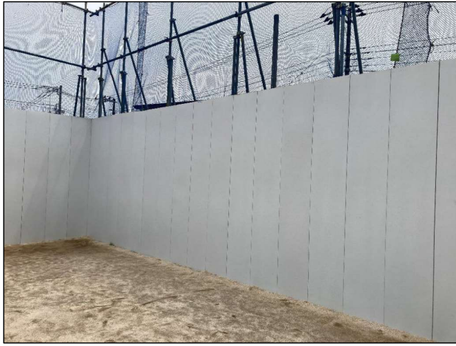
仮囲い:フラットパネル(H=3.0m)
