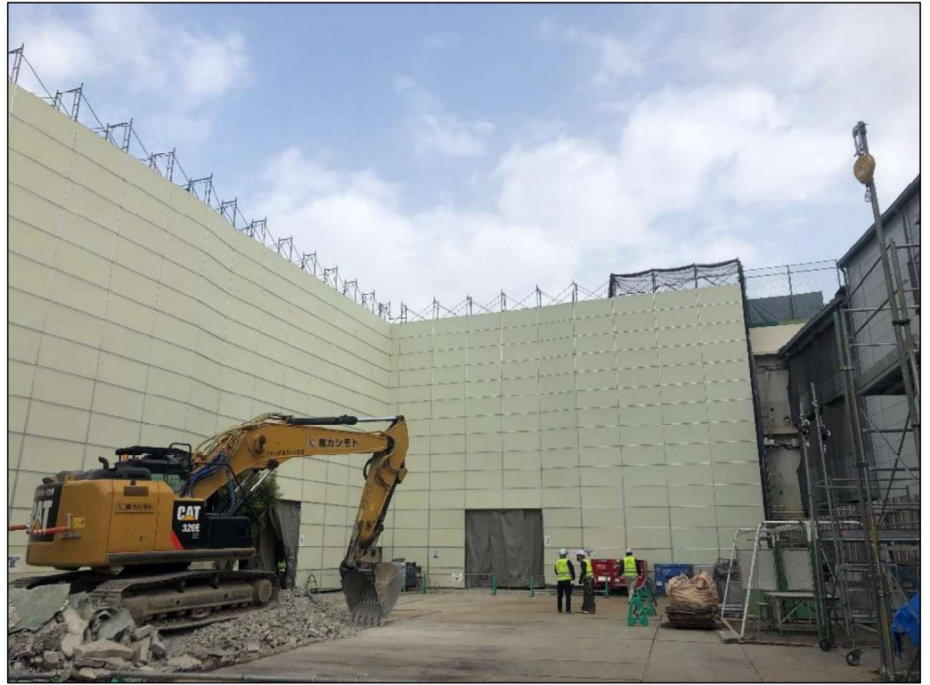
足場:防音パネル
