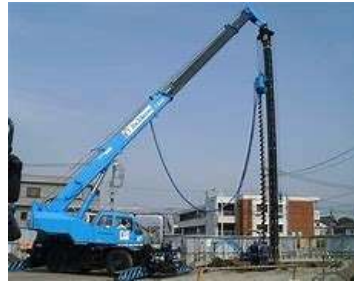
山留H鋼打込
