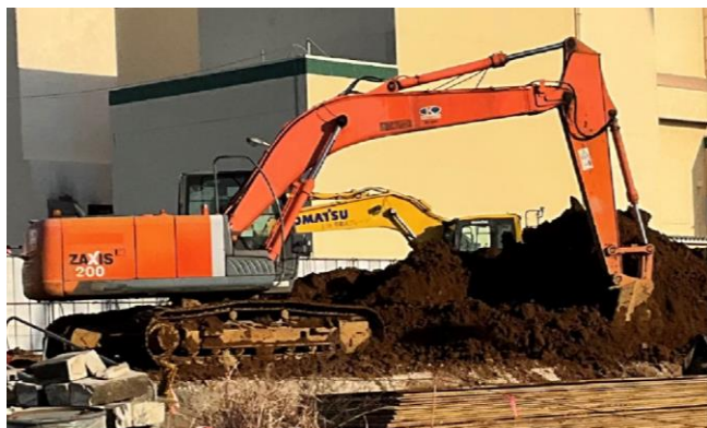
土砂掘削バックホウ
