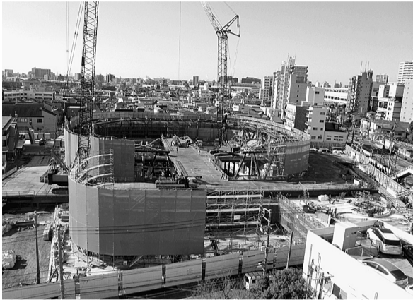
工事の状況(平成23年3月現在)
