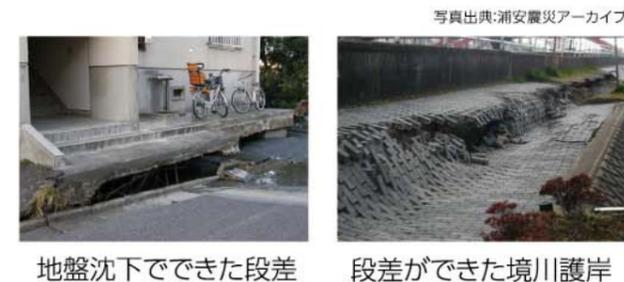
地盤沈下でできた段差 段差ができた境川護岸
