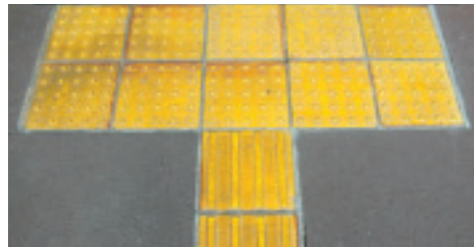
目の不自由な人のための点字ブロック
