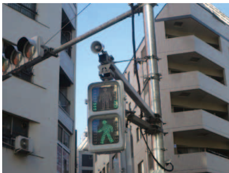
【押しボタン式音響式信号機の事例写真】
