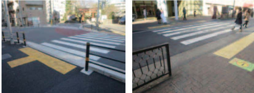
横断歩道脇に「横断防止柵」を設置した事例
