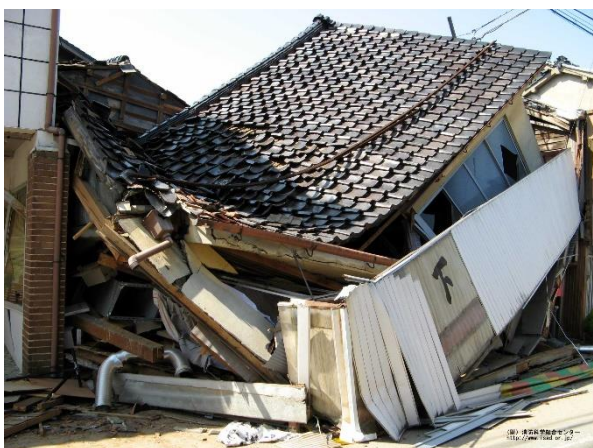
[木造住宅の倒壊]
