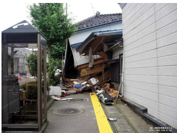
[木造住宅の倒壊による道路閉塞]
