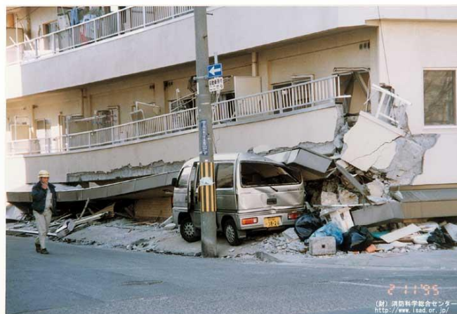
[マンションの倒壊]
