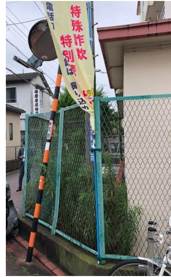
カーブミラーの 損傷
