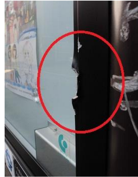
区設掲示板の 損傷
