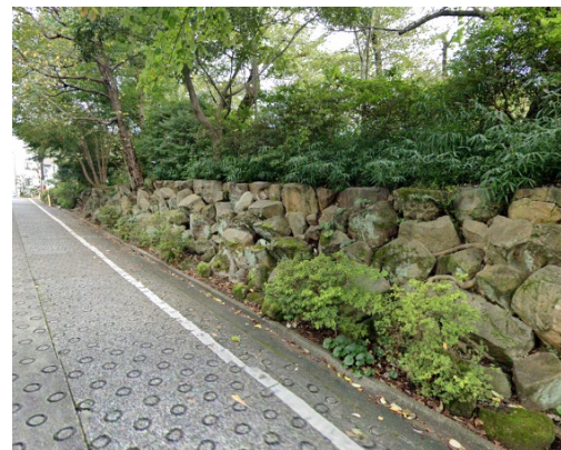
生物生息空間を創出する擁壁工事
