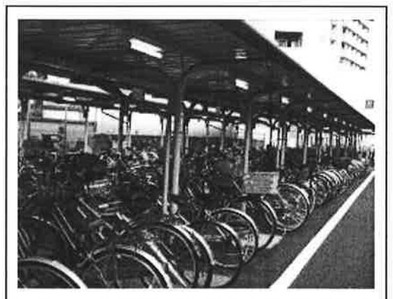
京急大島居駅前自転車等駐車場
