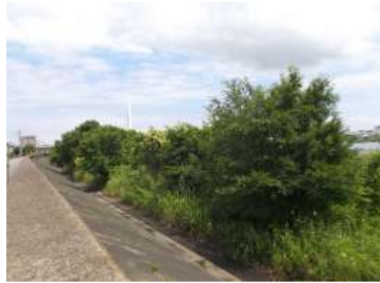
河畔林 (本羽田付近)
