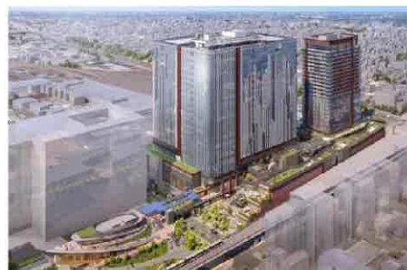
写真：大井町トラックス（工事中）
