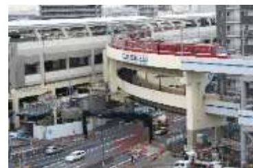
京浜急行線連続立体交差事業※
