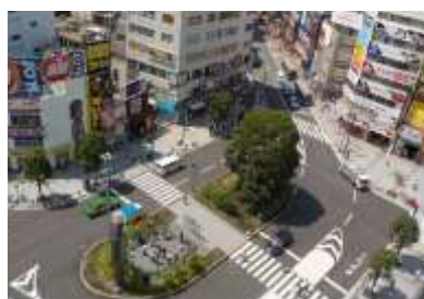
蒲田駅西口駅前広場初期整備
