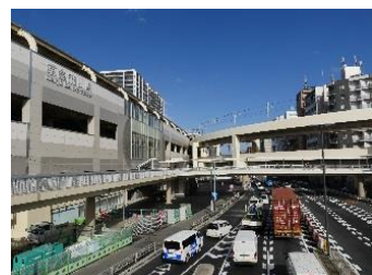
京浜急行線連続立体交差事業の高架化
