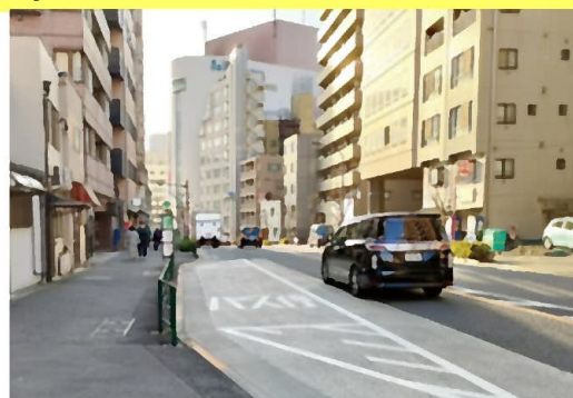
<品川区東大井5丁目付近> 補助第28号線整備済区間
