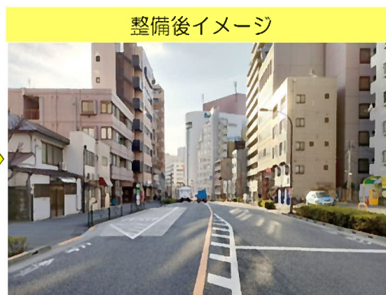
<品川区東大井5丁目付近>整備済区間
