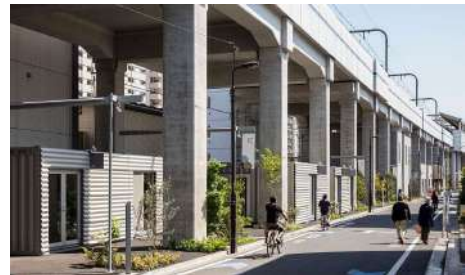
京急本線の高架下を活用した コワーキング施設「KOCA」(出典：東京都)
