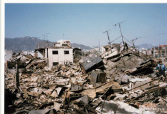
延焼火災の様子 (神戸市長田区・須磨区) 出典: 一般財団法人消防防災科学センター
