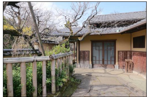
図 2-7-3 旧川端龍子邸(主屋)の外観
