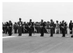
羽田新A滑走路完成(昭和63年)
